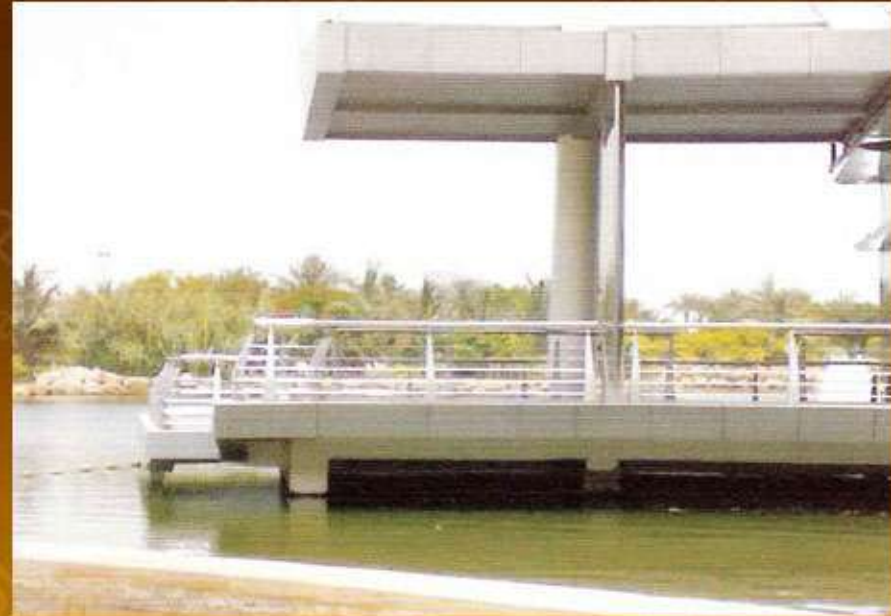
Zabeel Park Fencing
